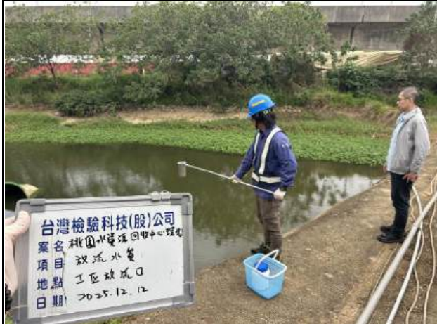
監測項目：放流水 監測地點：工區放流水 監測日期：114.12.12
