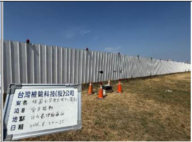
監測項目：噪音振動 監測地點：污水處理廠廠址 監測日期：114.08.24~25
