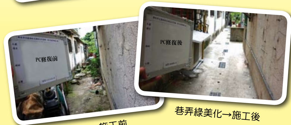
巷弄綠美化→施工前
