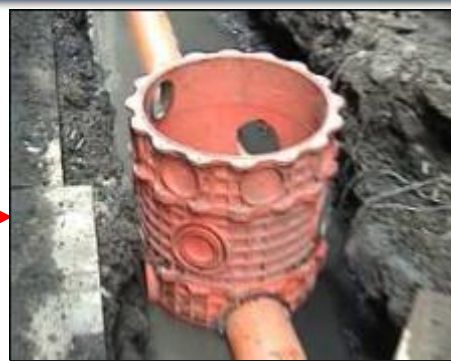
後巷開挖及污水設施埋設
