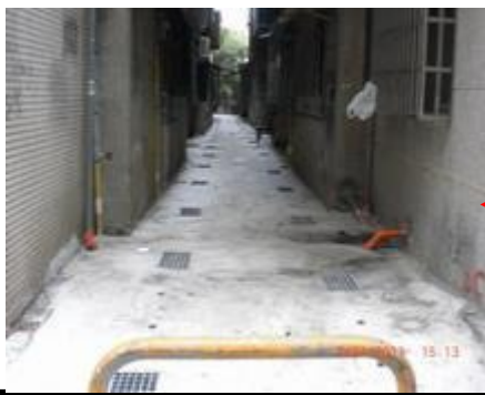
鋪設後巷混凝土地坪
