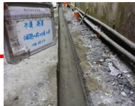
新建雨水排水溝
